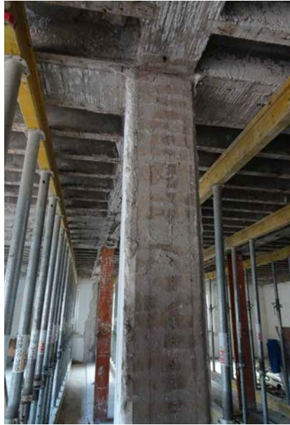
Abb. 16: Die Stützen unter der Rippendecke bestehen aus Ziegelsplittbeton
