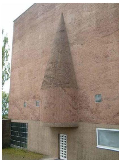
Abb. 2: Der Zustand der Fatima-Kirche in Kassel aus Sichtbeton mit Ziegelbruch ist – gemessen am Alter von ca. 60 Jahren – sehr gut. Es bestand nur vergleichsweise geringer Instandsetzungsbedarf, ...
