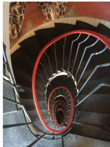
Abb. 8: Blick ins Treppenhaus – nur die Wandmalereien sind neu
