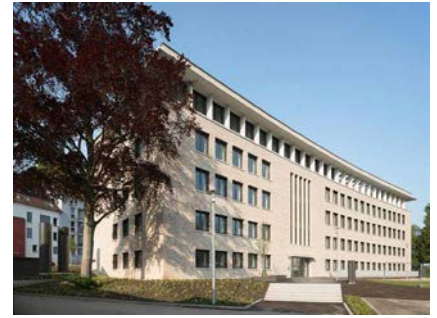
Abb. 12: Eine einheitliche Klinkerfassade umschließt den neuen und den alten Baukörper
