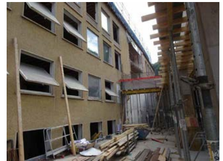
Abb. 13: Das Atrium in der Bauphase. Links ist die intakte Fassade des Bestandsbaus aus den 1950er-Jahren zu sehen.
