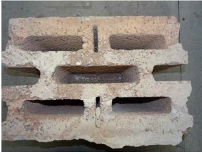
Abb. 15: Im ursprünglichen Teil des Technischen Rathauses wurden Leichtbetonmauersteine mit Ziegelsplitt verbaut. Die Mauerwerke daraus können weiter genutzt werden.
