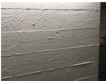
Abb. 6: Die beim Bau bretteschalte Betonoberfläche im Inneren des Gebäudes wurde später weiß beschichtet
