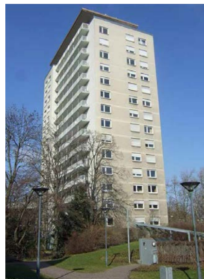
Abb. 4: Das Studentenwohnheim Max-Kade-Haus in Stuttgart wurde 1953 aus Bauschuttbeton errichtet. Die Fassade und alle sonstigen Betonbauteile des Hochhauses sind bis heute im Originalzustand erhalten.
