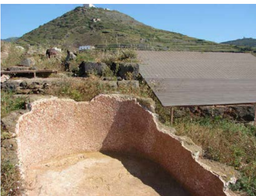
Abb. 1: Die 2.000 Jahre alte Zisterne auf der italienischen Insel Pantelleria besteht aus puzzolanischem Mörtel mit Ziegelbruch und -mehl. Sie ist auf der Wasserseite mit Opus Signinum »abgedichtet« und zum Teil so gut erhalten, dass sie noch heute als Wasserspeicher dienen kann.
